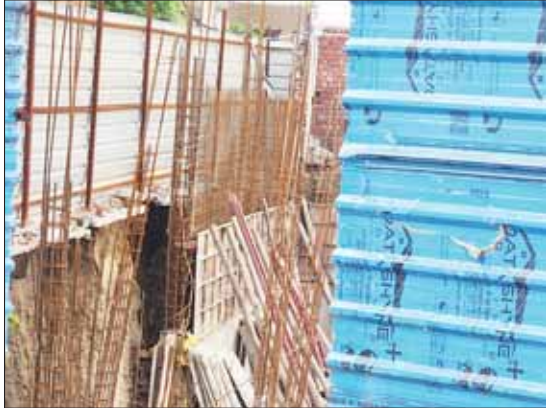
बेसमेंट निर्माण के दौरान सरकारी सड़क की निकली मिट्टी
